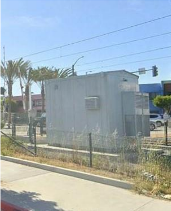
Example Train Control Bungalow (LA Metro, Los Angeles, California)
